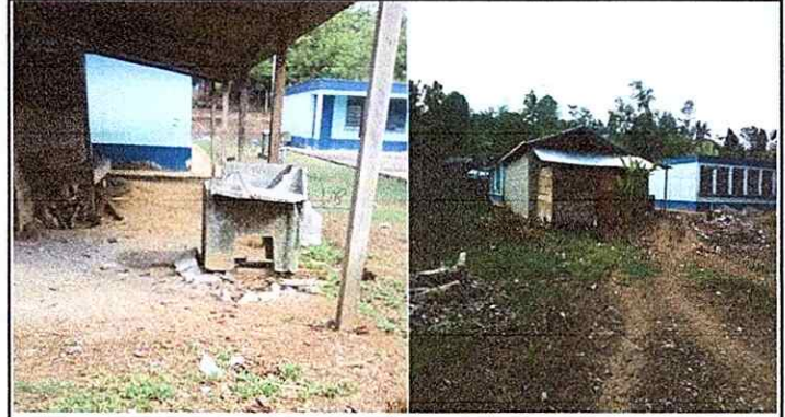
Foto 2: Rehabilitación interior y exterior de cocina
