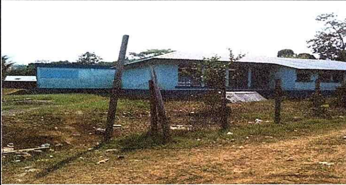
Foto 1: Remozamiento muro perimetral
